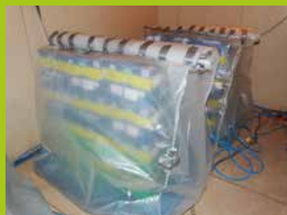
Figura 2. Carpas de AC instaladas dentro de la cámara de frío a 6°C.
